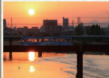
阪堺電車 大和川鉄橋
