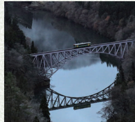
JR只見線 第一只見川橋梁
